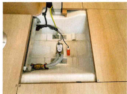
Leichter Zugang zu den Kielbolzen. Der Rest der Bodenbretter ist jetzt verschraubt.
